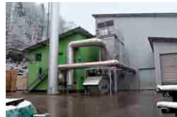
– Das Biomassekraftwerk in Nordrach produziert nicht nur Strom, sondern auch Wärme für die Trockenhalle des Betriebs und dreißig Haushalte.
